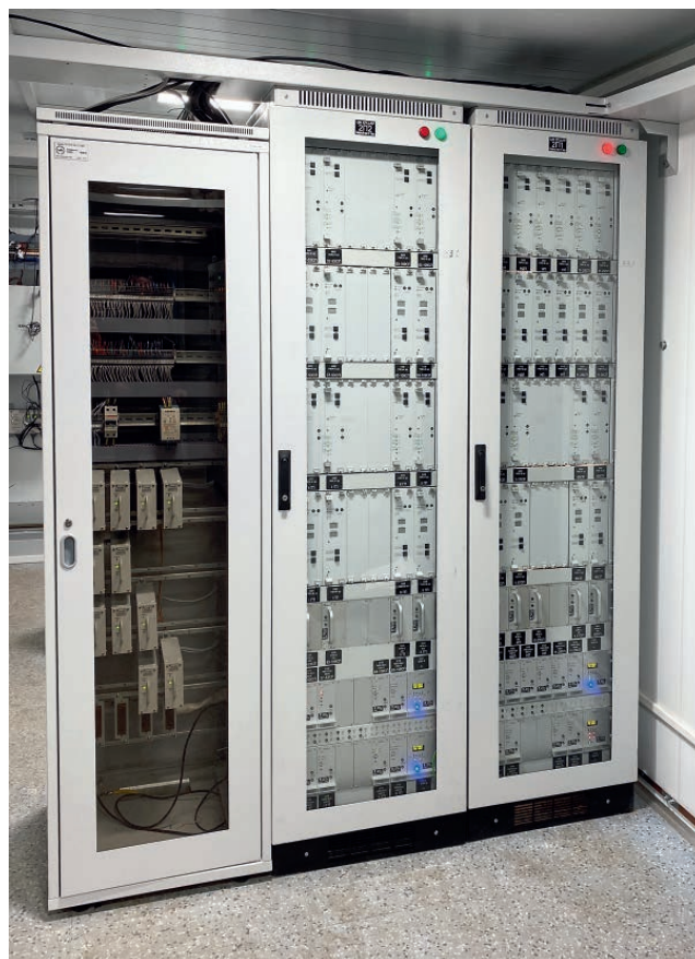
Аппаратура цифрового модуля ЦМ-КРЦ-АР
