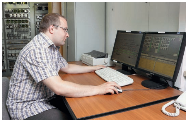
Проверка работы МПЦ-Е сервисным инженером на Московской дороге
