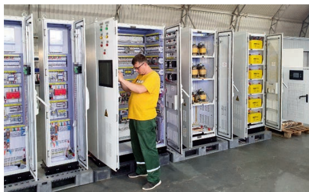
Монтаж питающей установки УЭП-У-М
